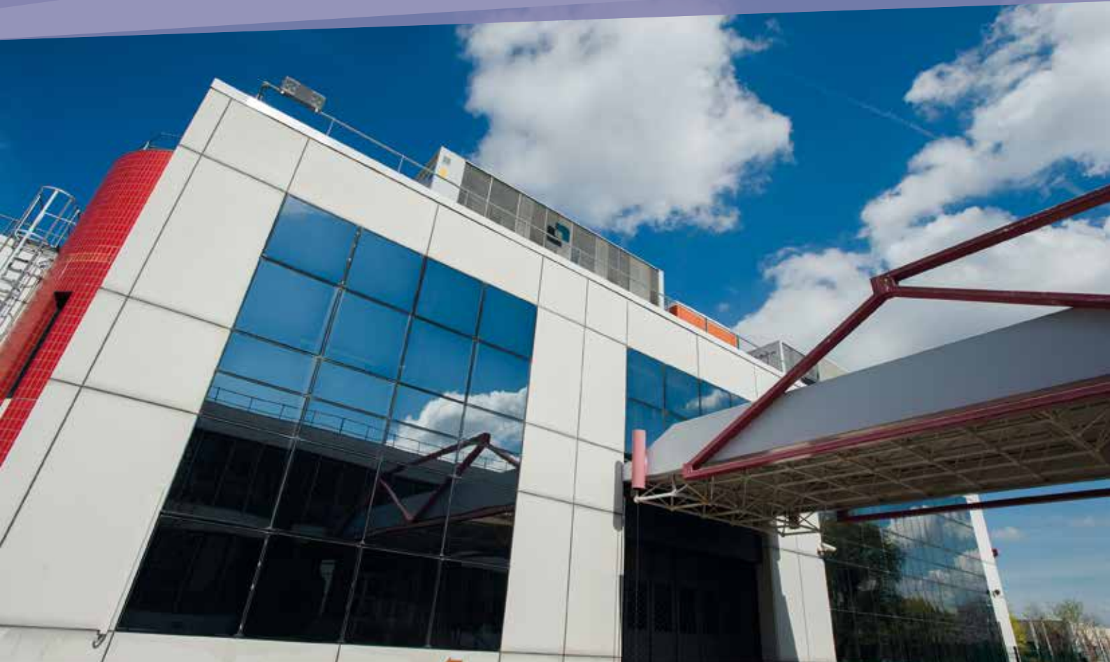
Le centre informatique douanier rénové est l'un des data centres majeurs de l'administration française.
