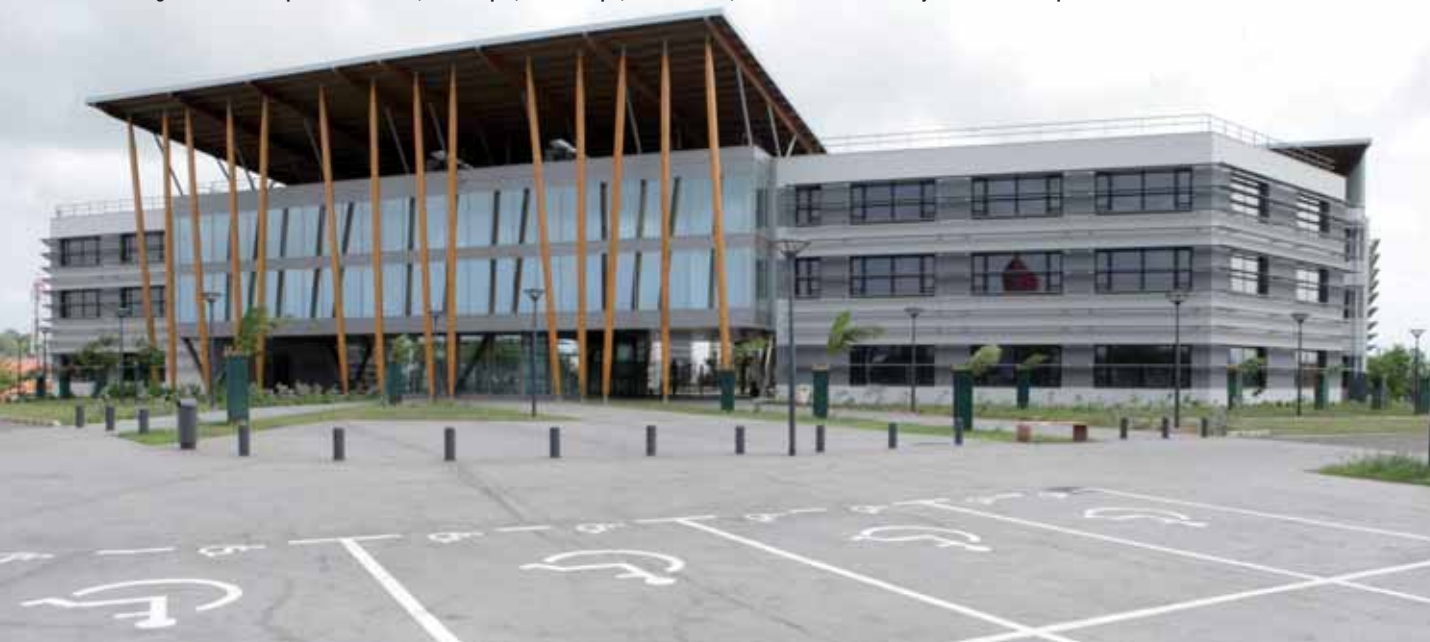
La Chambre régionale des comptes des Antilles, Martinique, Guadeloupe, Saint-Martin, Saint-Barth et de la Guyane au cœur du parc d'activité HQE de la Providence.
